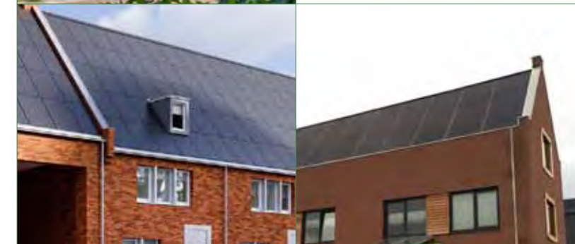
Zonne-panels geïntegreerd in dakvlak, vlakke dakvlakken
